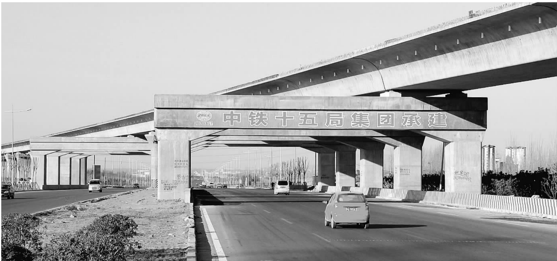
跨四港联动高架桥
