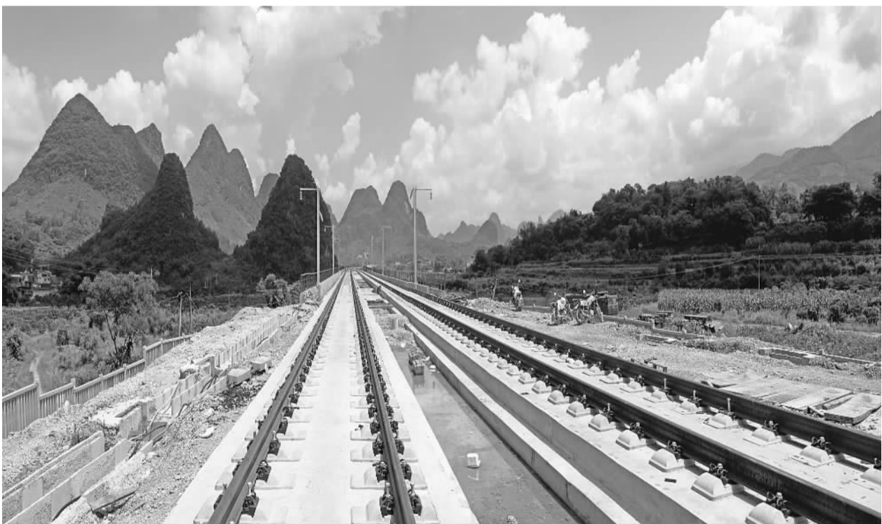
高铁铺进桂林
