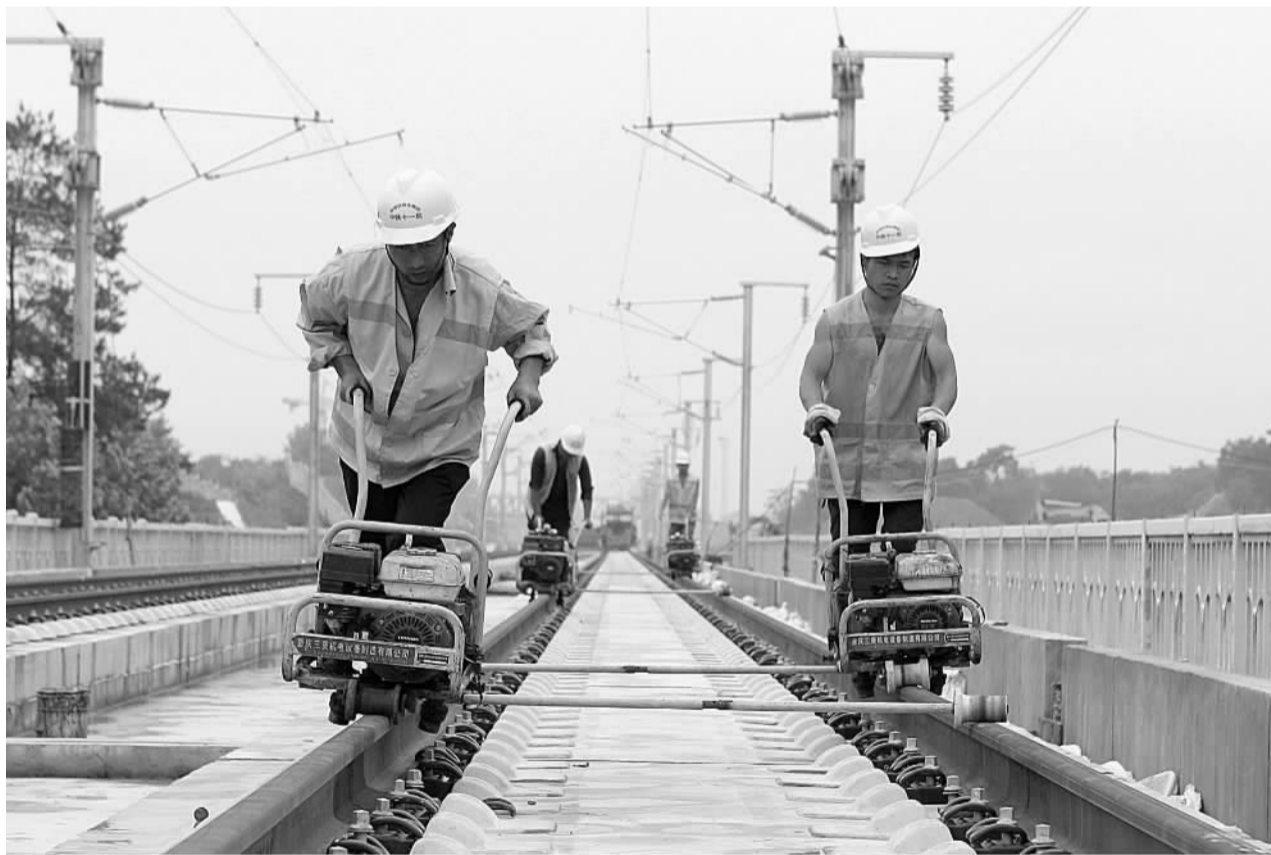
担负合福客专安徽境内正线427(双线)公里铺轨任务的十一局集团三公司,以每天近10公里的速度,将500米长轨向前延伸。图为工人们在进行长轨紧固作业。徐云华 摄
