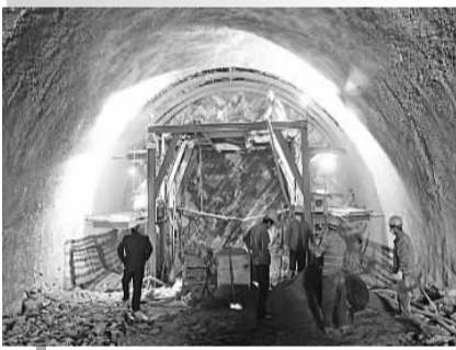
隧道喷锚支护作业
