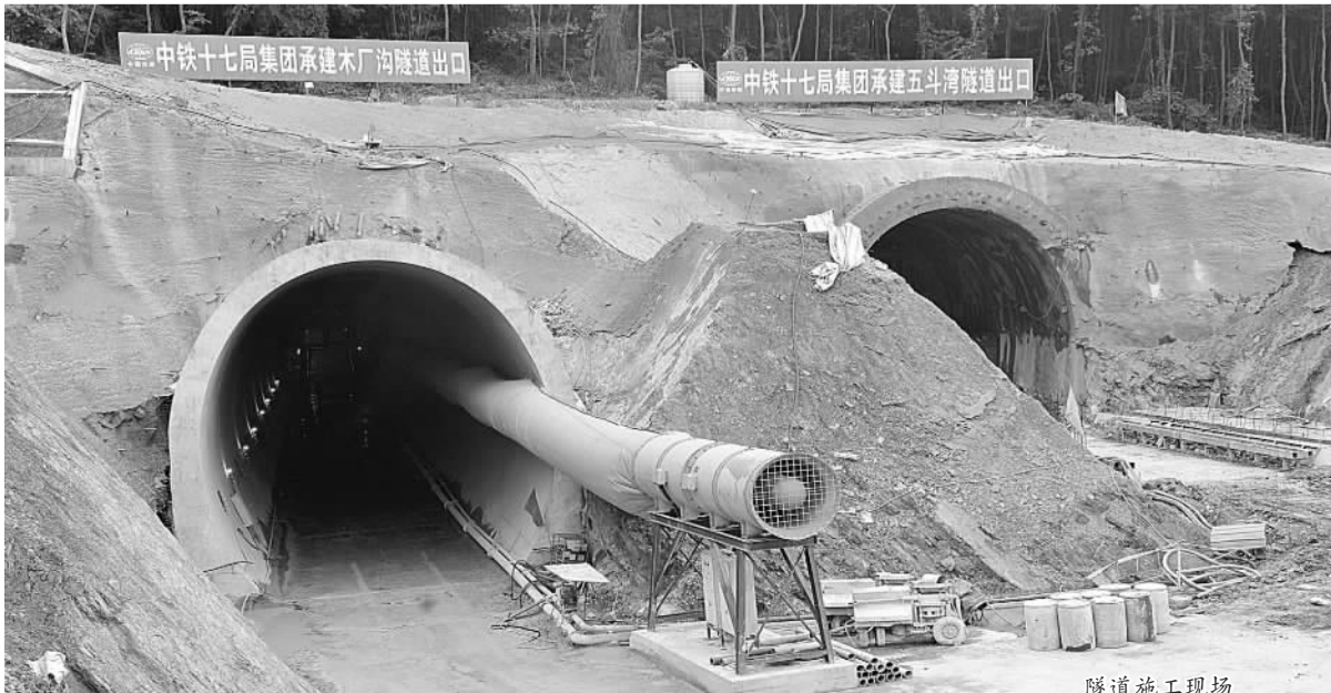
隧道施工现场
