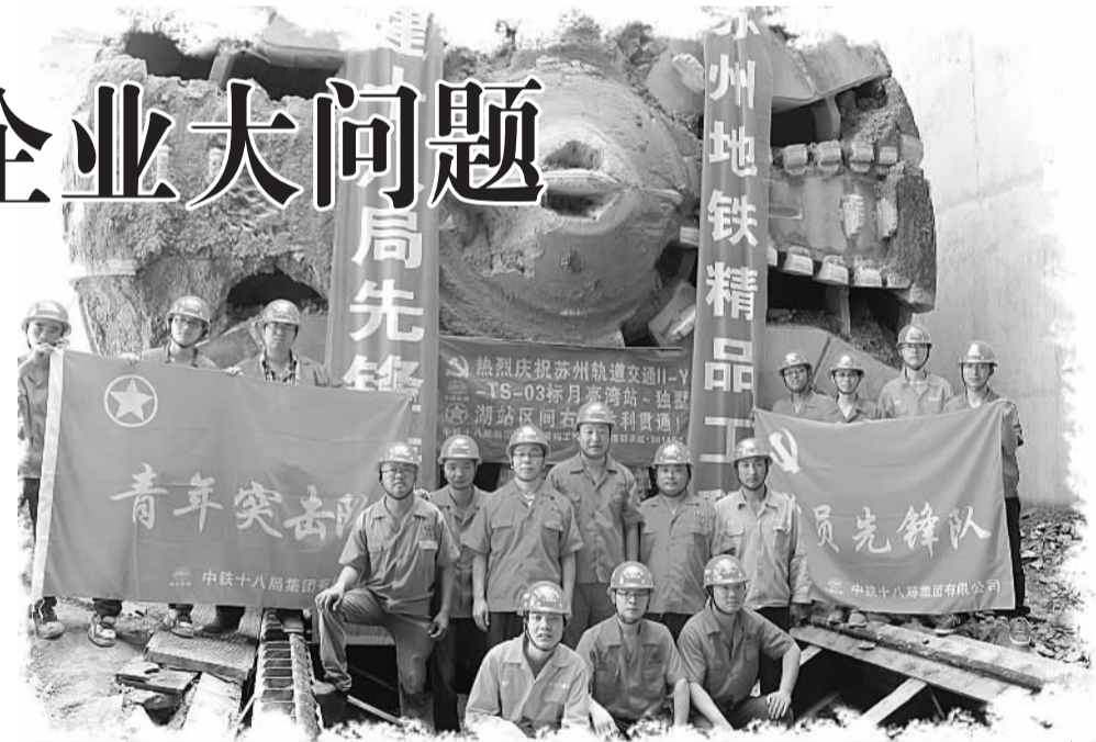
四公司承建的苏州地铁月亮湾至独墅湖区间顺利贯通。
