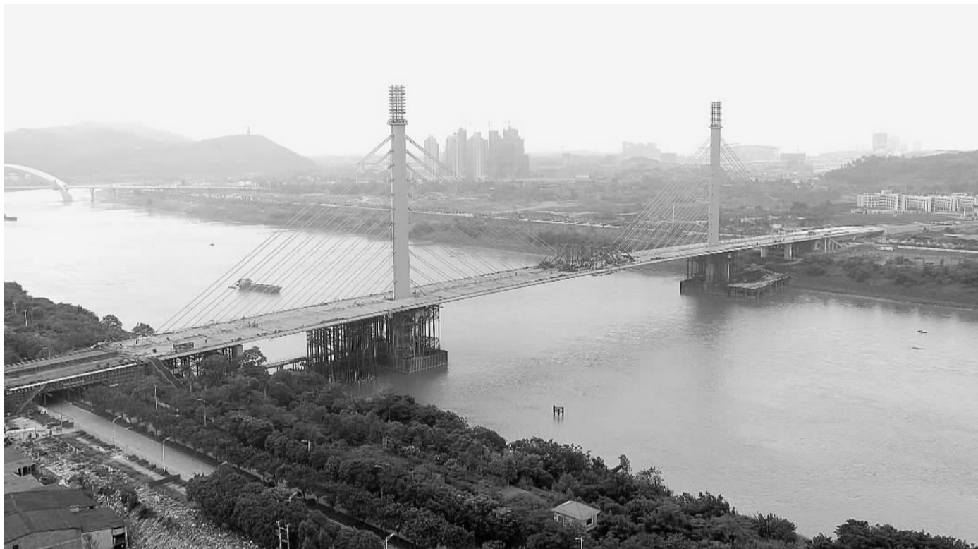
南宁五象大桥是第四十五届世界体操锦标赛的配套项目,也是南宁市重点工程,主桥有一长达590米的连续钢箱梁,施工难度极大。十八局集团二公司巧妙衔接各道工序,确保了各项指标处于受控状态,近日大桥提前合龙。图为360吨钢箱梁节段吊装现场。赵江平 摄
