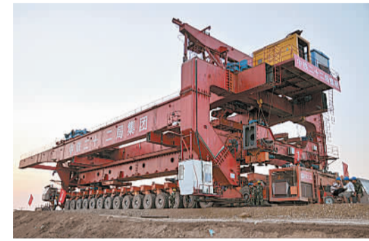
架桥机在作业
