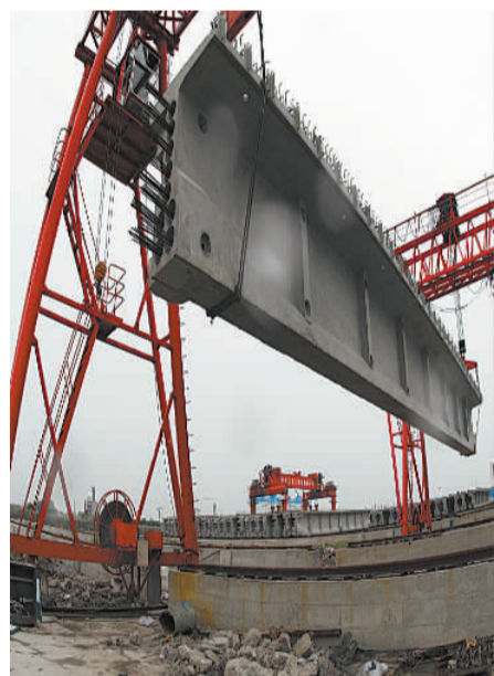
现场吊运桥梁
