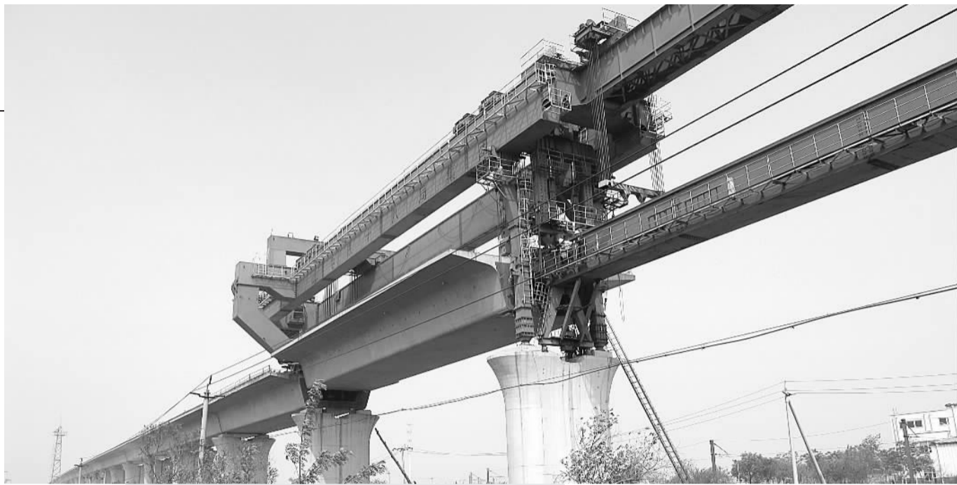
京津城际延伸线铺架
