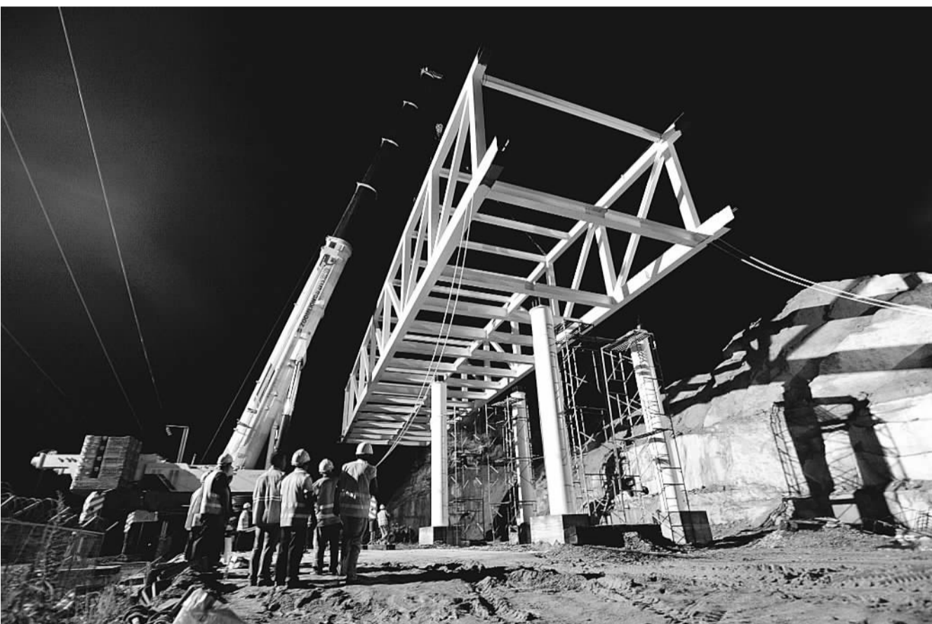
惠安西站是福建省第一条城际快速客运通道福厦高铁线上增设的车站工程。图为6月25日,十一局集团建安公司进行Ⅱ级封锁施工,正在吊装惠安西站旅客天桥。
