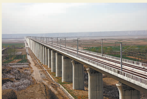
黄河特大桥接触网布局
