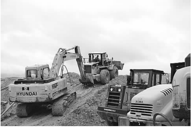
十七局集团四公司大(庆)广(州)高速3标项目克服南方阴雨天气给机械施工带来的困难,组成雨季机械运输突击队,冒雨完成业主下达的季度施工计划,在广州大广高速公路有限公司第一季度16家施工单位施工综合考评中,取得第三名的好成绩。图为机械作业施工现场。张鹏 张广田 摄
