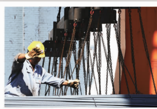
钢材吊装现场 李锦龙 摄
