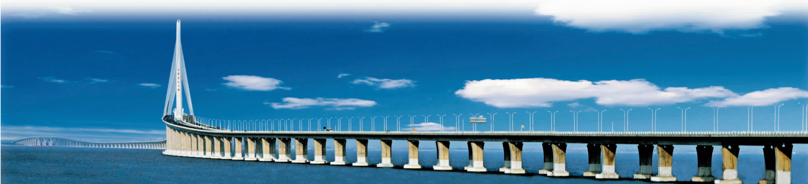
二十四局集团参建的上海长江大桥是目前世界上最大的公轨合建斜拉桥,2013年荣获中国土木工程詹天佑奖。高扬摄
