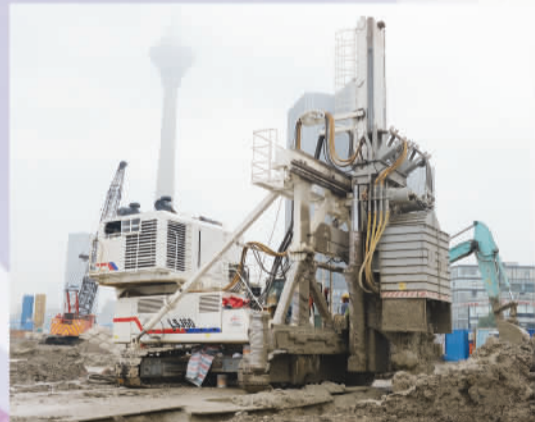
LSJ60 链刀式连续墙设备在天津鲁能绿荫里项目施工
