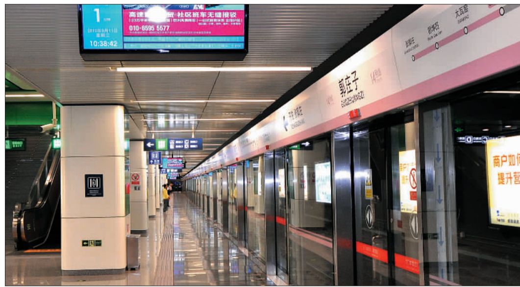
二十二局集团一公司承建的北京地铁14号线郭庄子车站荣获北京市结构长城杯。张洪柱摄
