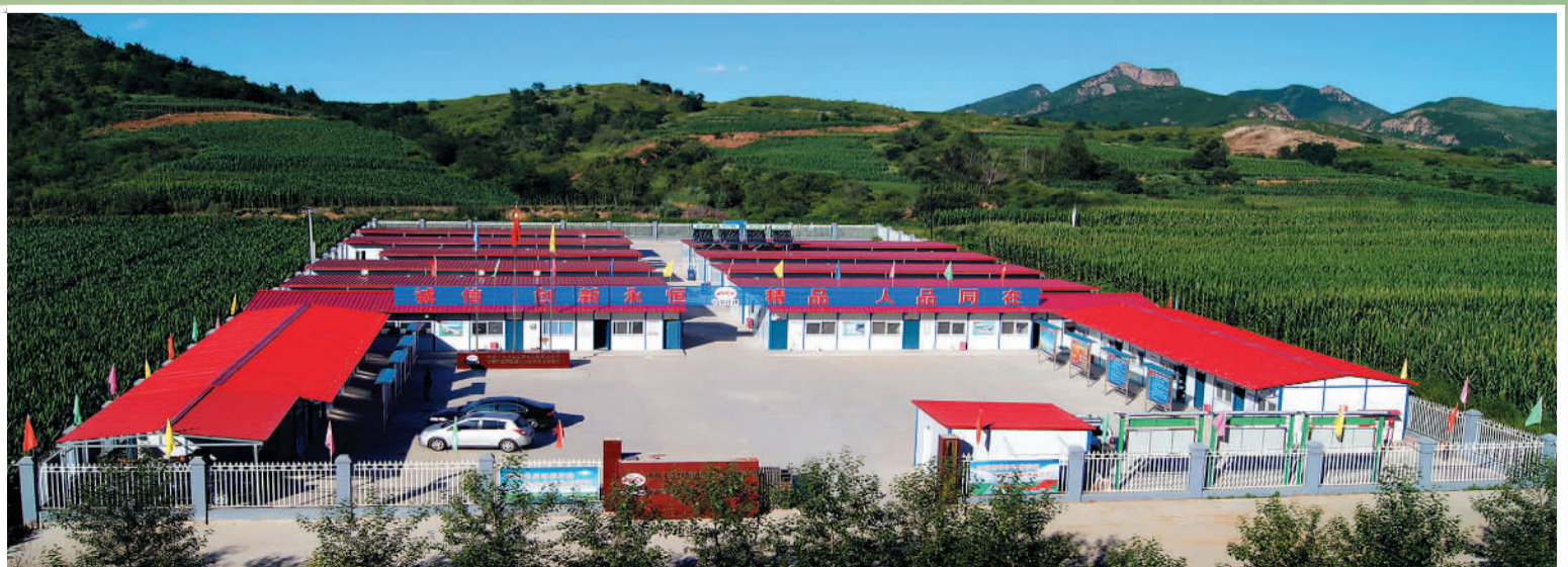
十五局集团把城市社区建设理念引入项目建家建线,开创了新型的工地“五型”社区,即建设服务型、和谐型、学习型、文化型、民主型工地社区。图为绿色环绕的十五局集团七公司张(家口)承(德)高速公路项目部。 张仲先 摄
