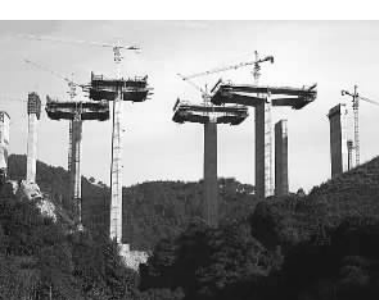
由十七局集团六公司承建的三明长深A3标马林大桥主墩最高达104米。项目部自行设计并采用新型的三角异形柱施工工艺,取得了两项专利。图为马林大桥施工全景。余福祺 摄
