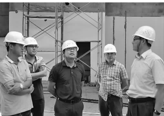
公司总经理张永军(中)与副总经理兼项目经理刘本党(右)在施工现场。
