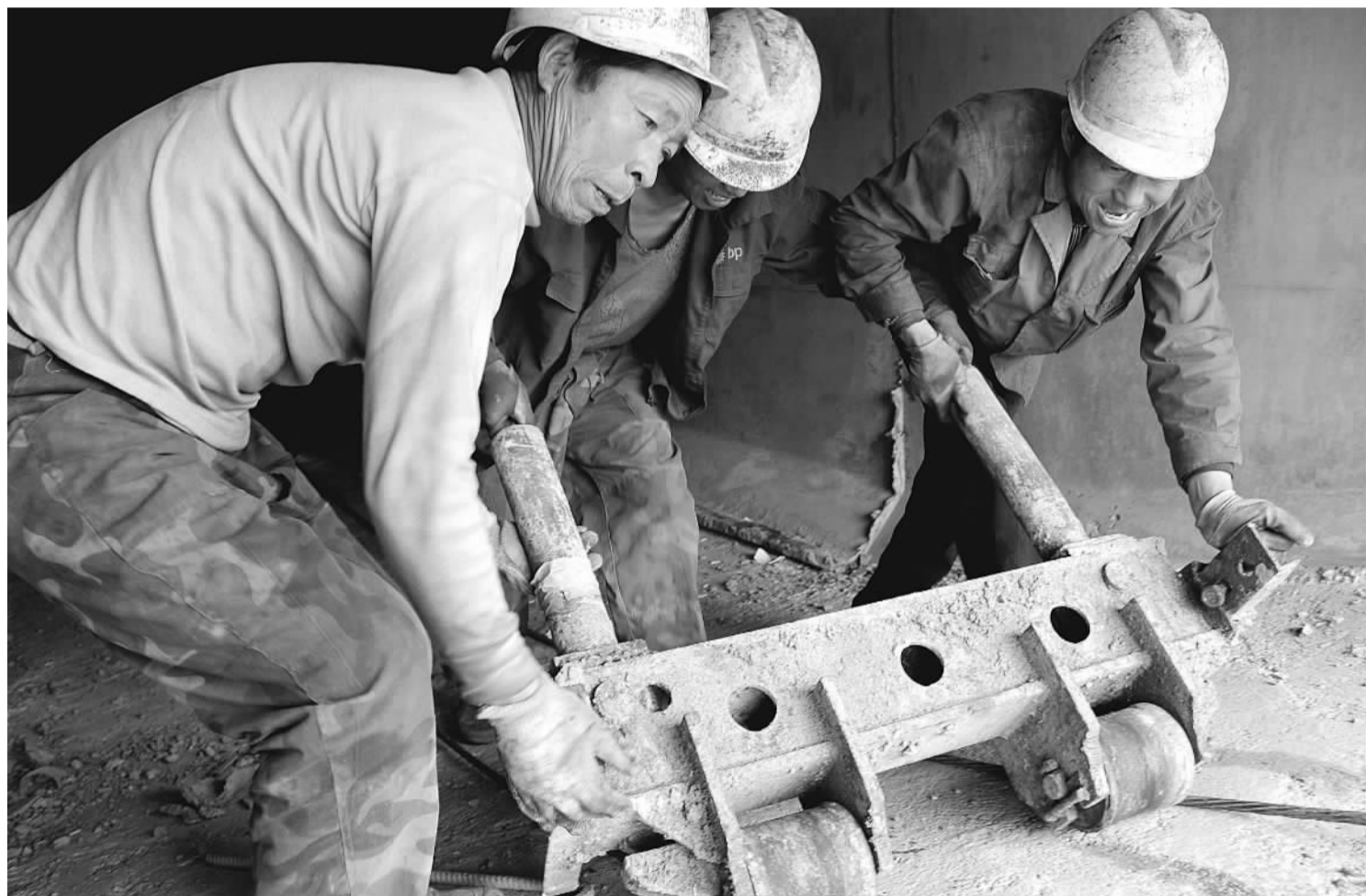
十八局集团一公司三浙项目在确保工程质量、进度的同时,狠抓施工现场的安全管理,加强安全防护设施的检查维护,堵塞漏洞,确保施工安全。图为工人施工时的场景。 王强强 摄
