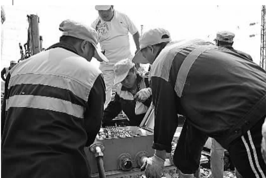
道岔安装施工
