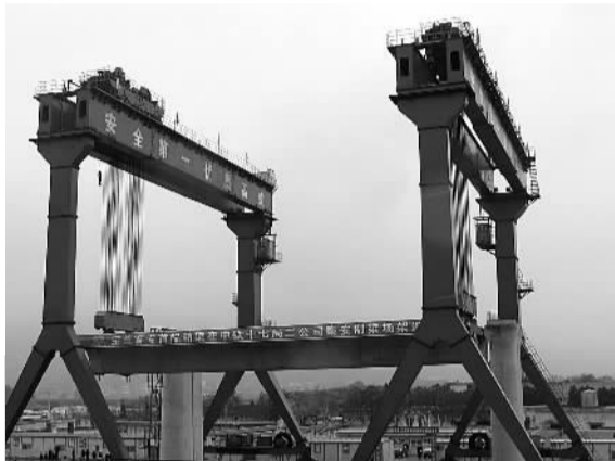
首根箱梁架设
