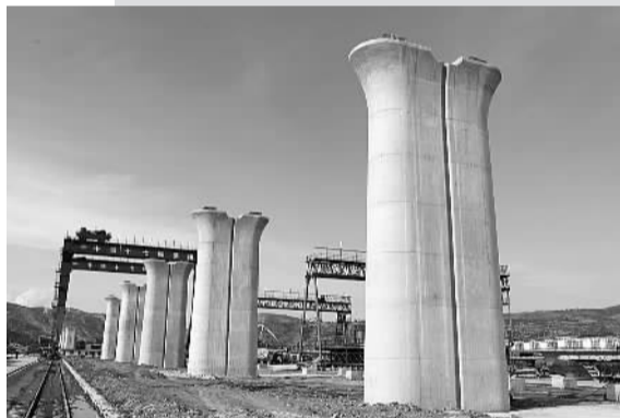
内实外美的桥墩
