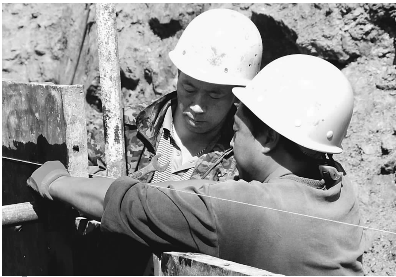
十八局集团一公司青岛地铁 3 号线项目部严控施工生产的关键环节，重点控制好节点工期，力争把影响施工进展的制约因素降到最低，确保现场施工生产快速有序推进。图为工作人员在井下进行施工作业。王强强 摄
