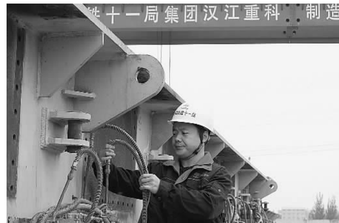
吴虎正在检查500吨架桥机电液
