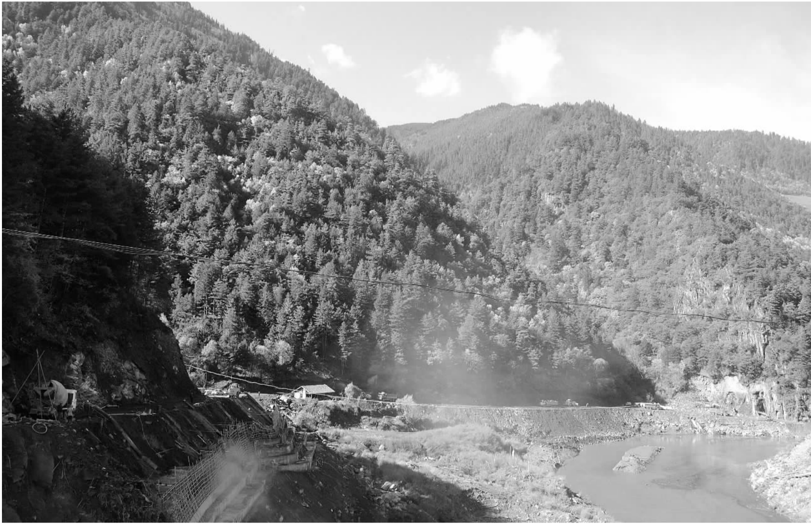
建设者劈山破水抢通道。
