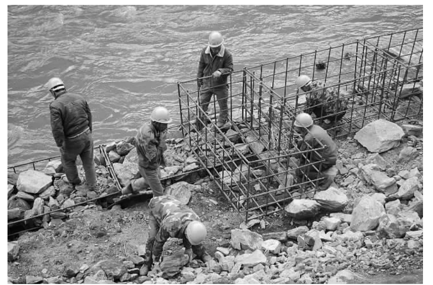
施工人员用钢筋笼固结石头防止护坡滑动。
