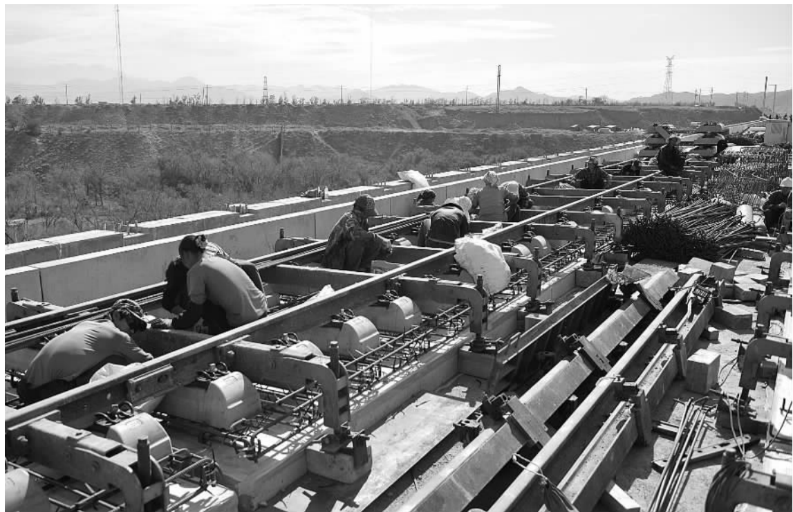
道床板钢筋绑扎
