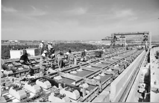
员工正在进行道床板施工抹面作业
