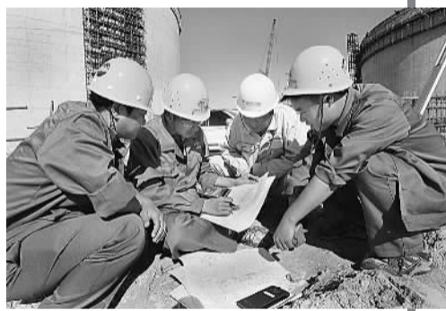
工程技术人员在研究解决施工难题
