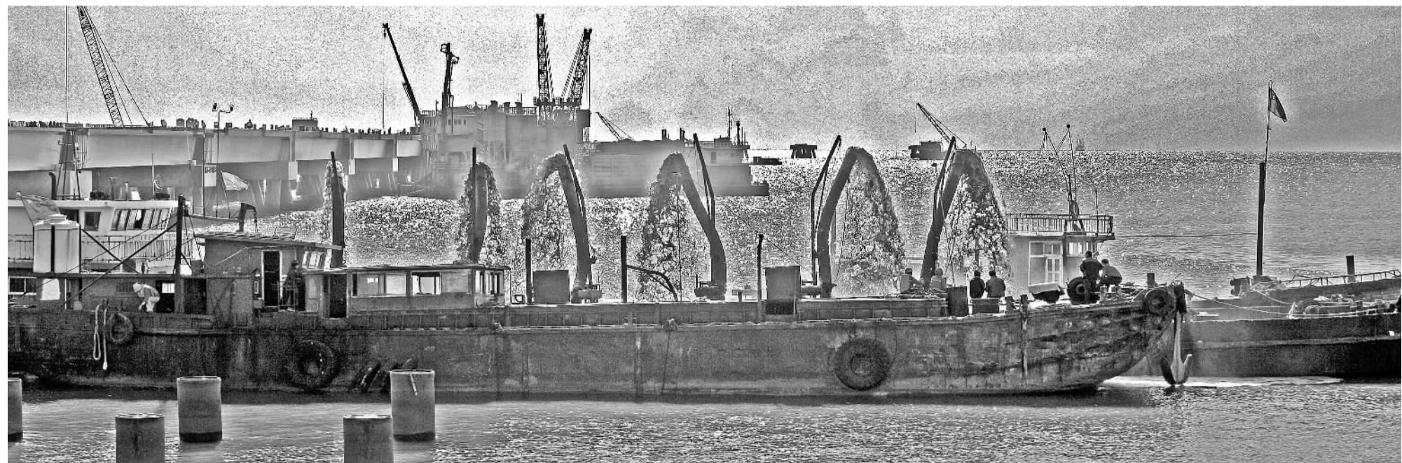
抽沙船在进行进口基础抽沙作业
