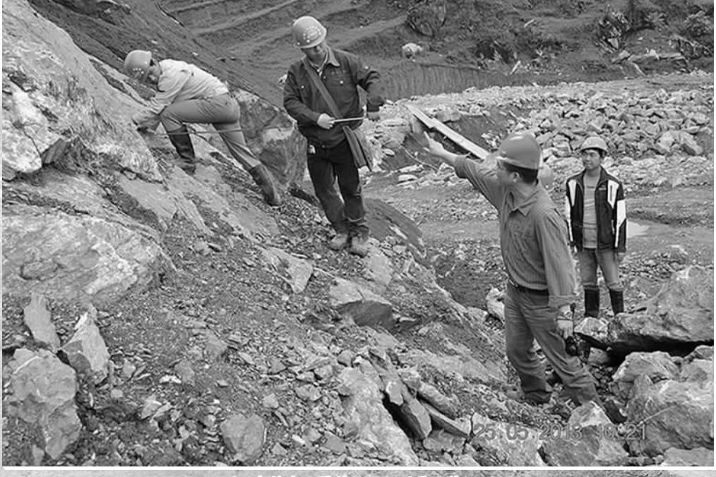
项目部技术人员精心做好测量工作。
