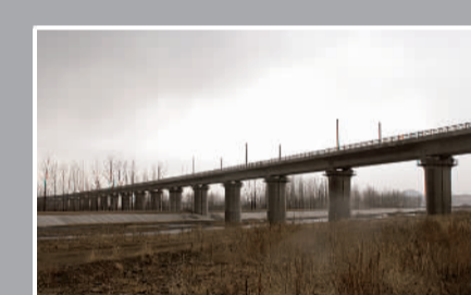
朝阳河特大桥
