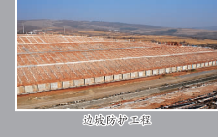
路基附属工程
