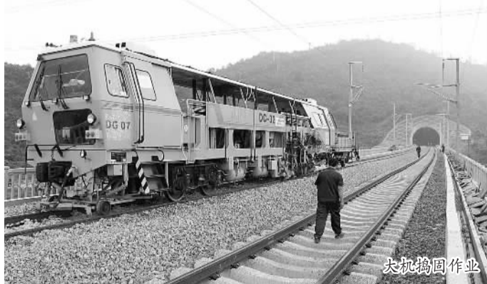
大机捣固作业
