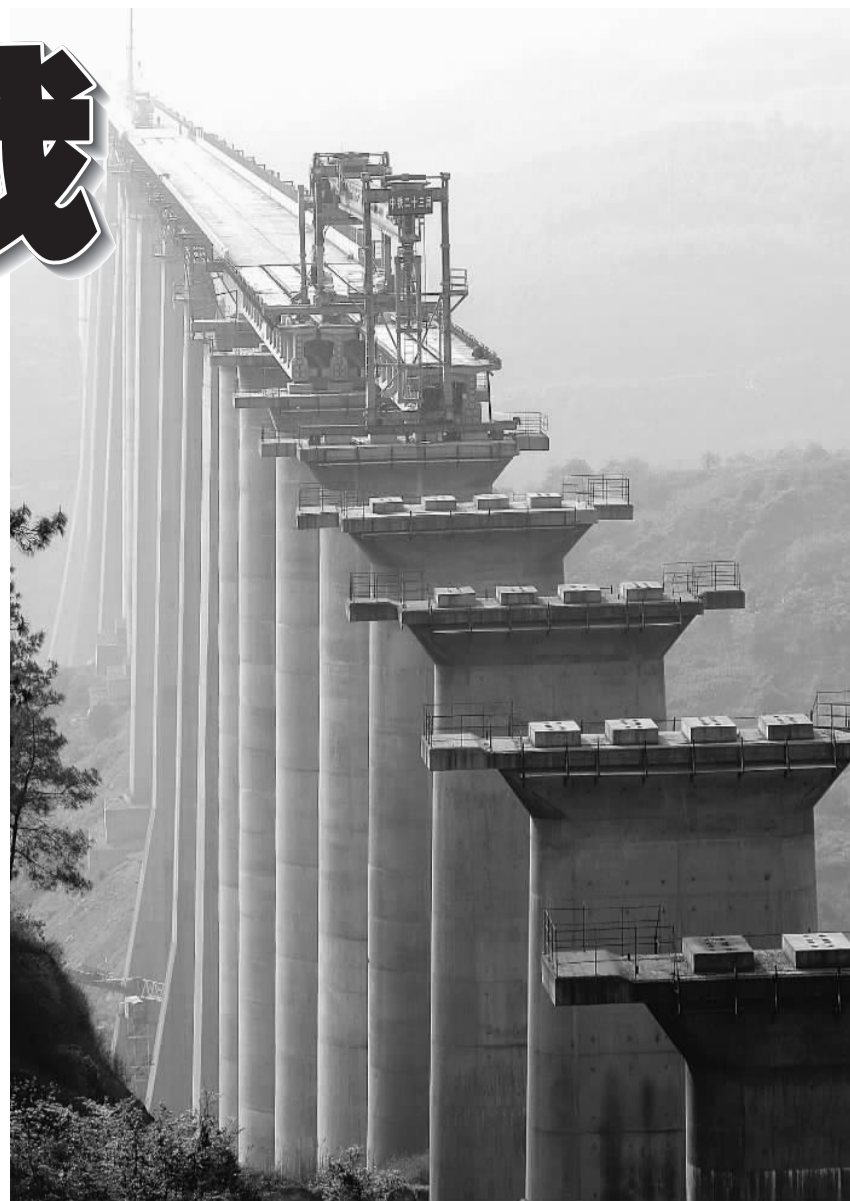
架梁施工通过高137米的蔡家沟双线特大桥 周安才 摄
