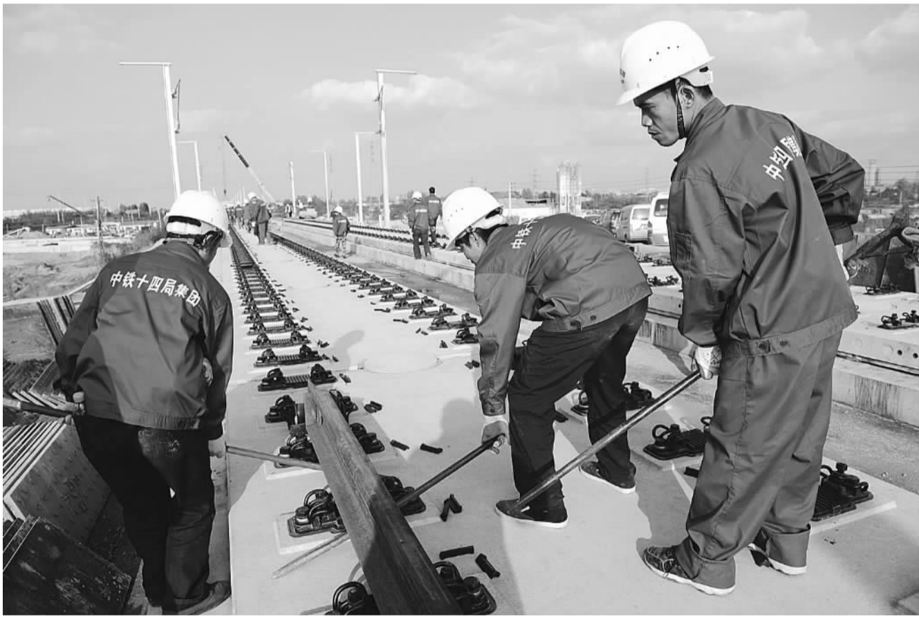
11月5日下午,十四局集团五公司铺轨工人在成绵乐客专旌阳站铺设500米长钢轨,标志着我国西南地区首条开工建设的高速铁路成绵乐客专全线进入攻坚收尾阶段。担负铺轨任务的五公司需铺轨528.25公里,目前已完成125公里。刘福昌 摄
