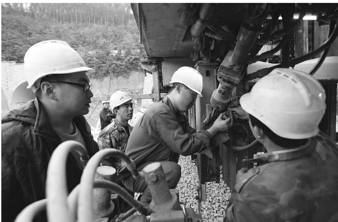
近日,湘桂高铁进入通车前最后的联调联试阶段。二十二局集团二公司克服地势复杂、施工任务重、验收标准高、工期压力大等重重困难,优质高效地完成了铺轨任务。 陈旭 摄
