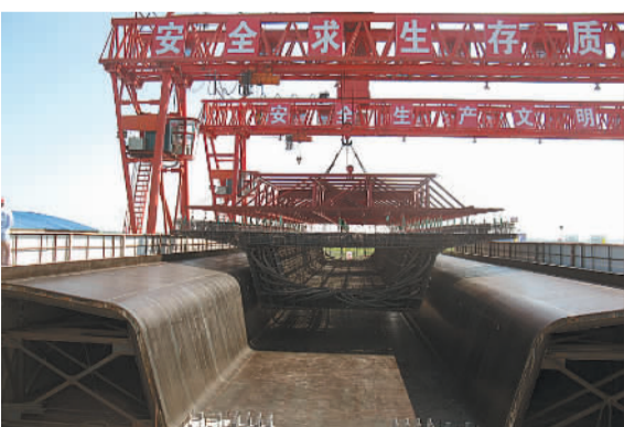
汉沽梁场进行箱梁预制施工。
