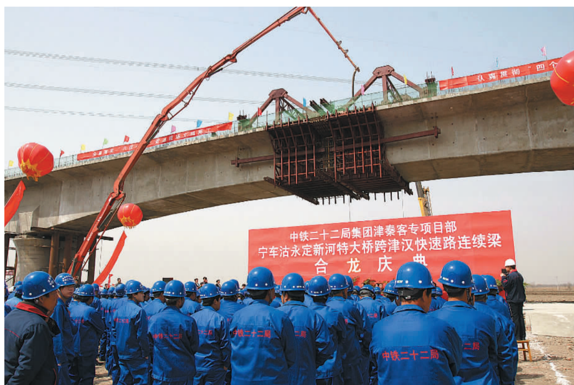
跨津汉快速路连续梁合龙仪式。
