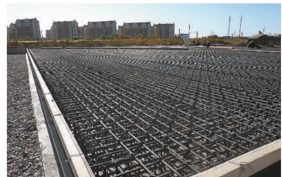
滨海北路路基底座板施工。
