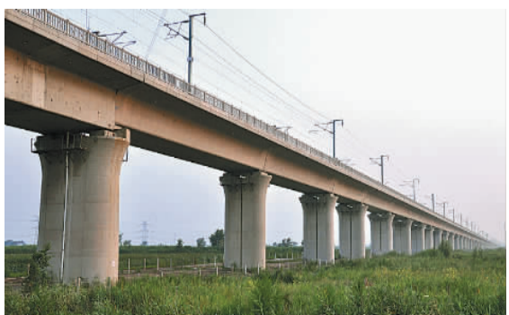
已竣工的宁车沽永定新河特大桥。
