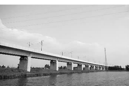
合武铁路江岸特大桥获国家优质工程银质奖。
