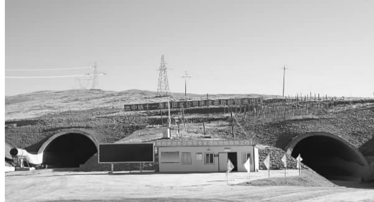
共玉公路高原冻土隧道施工。
