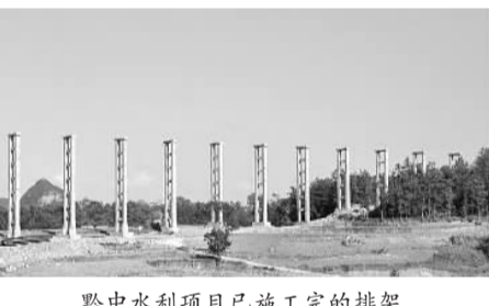
黔中水利项目已施工完的排架。
