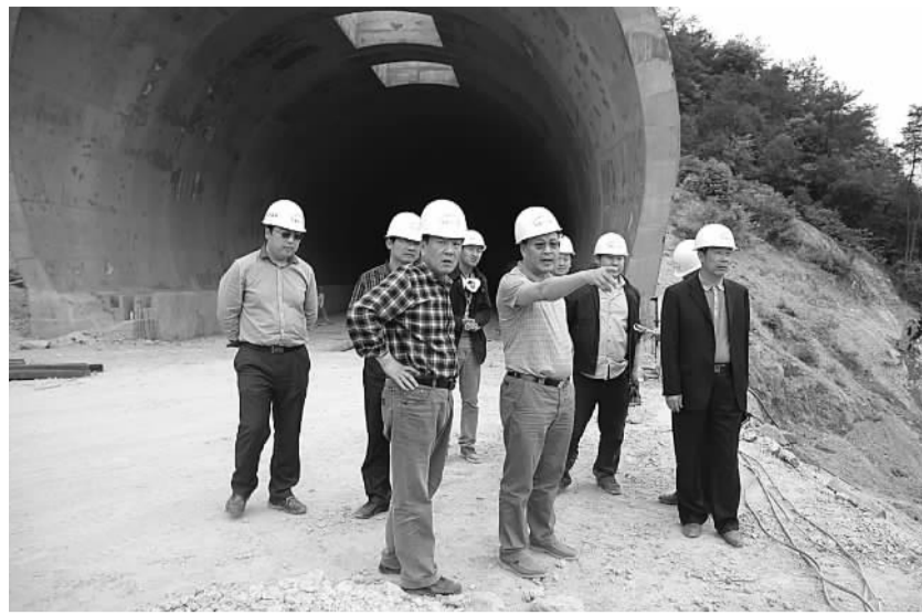
总经理王胜祖(中)带领执行力检查组在杭长项目查看施工现场。
