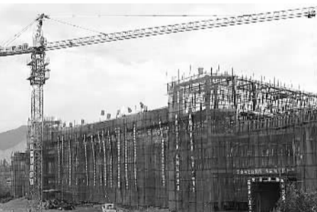
金昌站改项目喜封顶。
