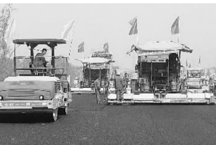
路面施工如火如荼。
