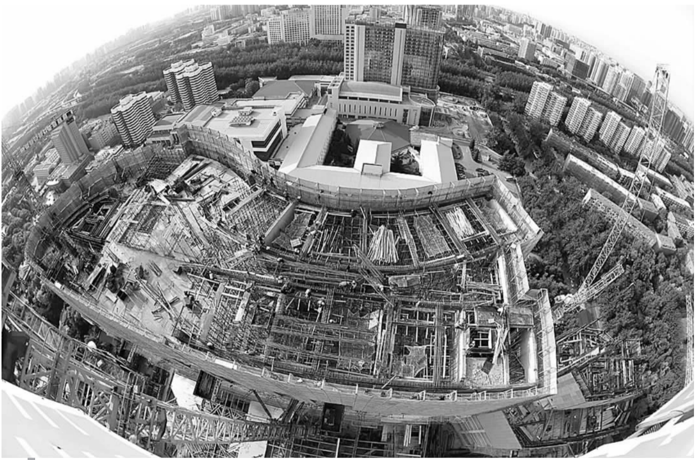
10月21日上午,十六局集团北京工程公司承建的燕翔饭店改扩建项目诺金饭店主体结构提前10天封顶。 本报记者 威海忠 摄
