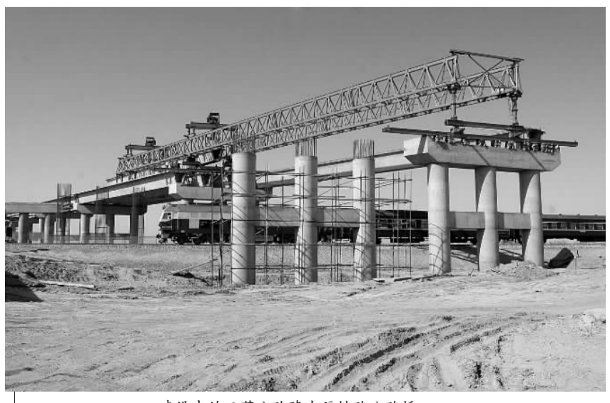
建设中的三莎公路跨南疆铁路公路桥。
