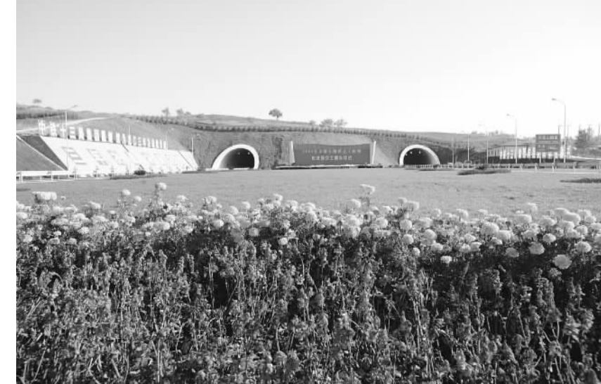
天恒山隧道——国内第一座严寒地区浅埋大跨黏土隧道
