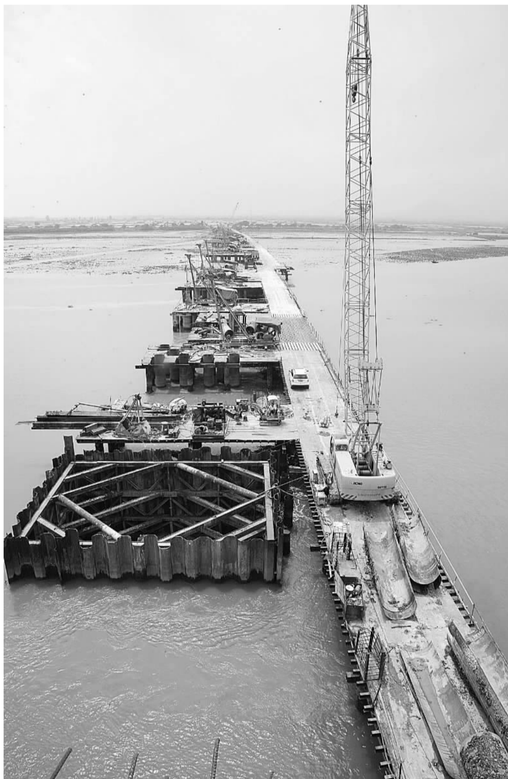
长沙湾特大桥位于广东省汕尾市海丰县,全长14.07公里,是厦深铁路第二长桥,先后跨越22个自然村、4条公路、17条河道及3.5公里的鱼塘,施工难度大,环保要求高。十八局集团二公司参建员工精心组织,科学施工,确保了施工生产顺利进行。图为最艰难的长沙湾特大桥海中墩展开全面施工。曹战锋 王忠霞 摄
