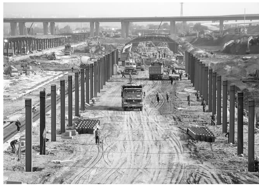
混凝土灌注及风雨棚钢结构立柱安装。
