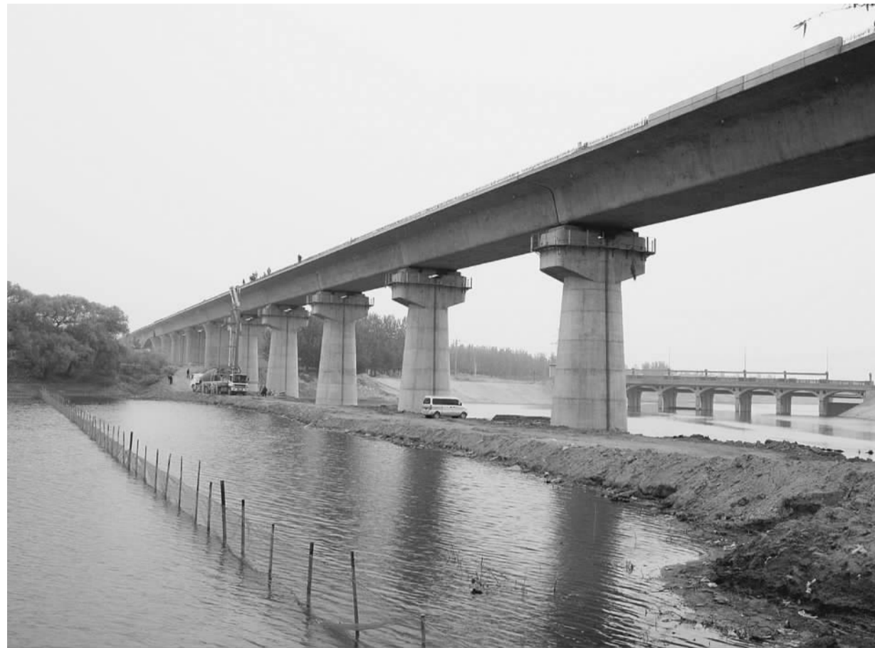
由十八局集团二公司承建的青沧特大桥地处河北沧州境内,全长17公里,经过两年的艰苦鏖战,全线最大跨度40米现浇简支梁成功跨越渤海入海排洪河道——子牙新河。图为青沧特大桥底座板混凝土浇筑施工。张骥摄
