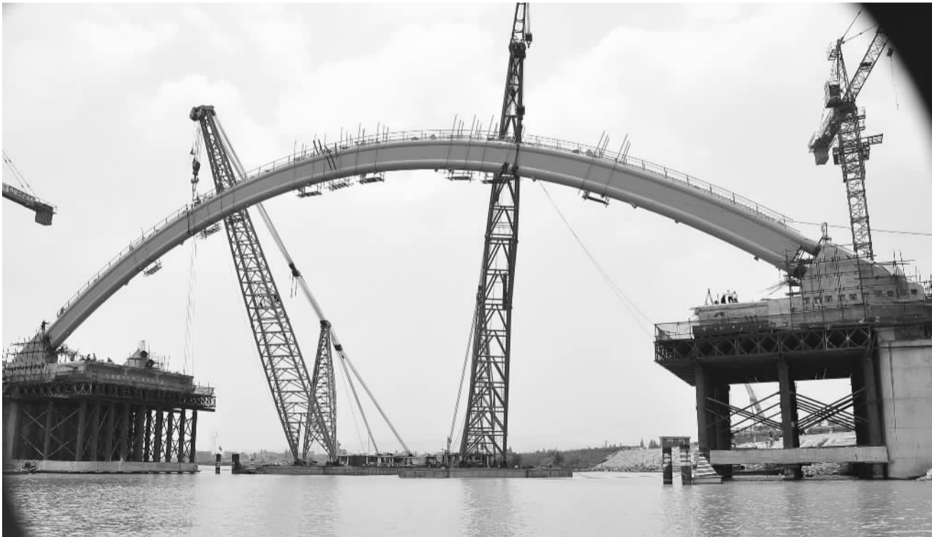
6 月 4 日,二十四局集团南昌建设公司安全完成宁杭铁路客专 NHZQ-4 标段京杭运河特大桥跨东苕溪 1-96 米系杆拱拱肋整体吊装,比原计划提前 1 天,成为宁杭铁路客运专线全线最早开装的施工单位。图为第一片钢管拱(拱肋)吊装成功的情景。 史华兴 摄
