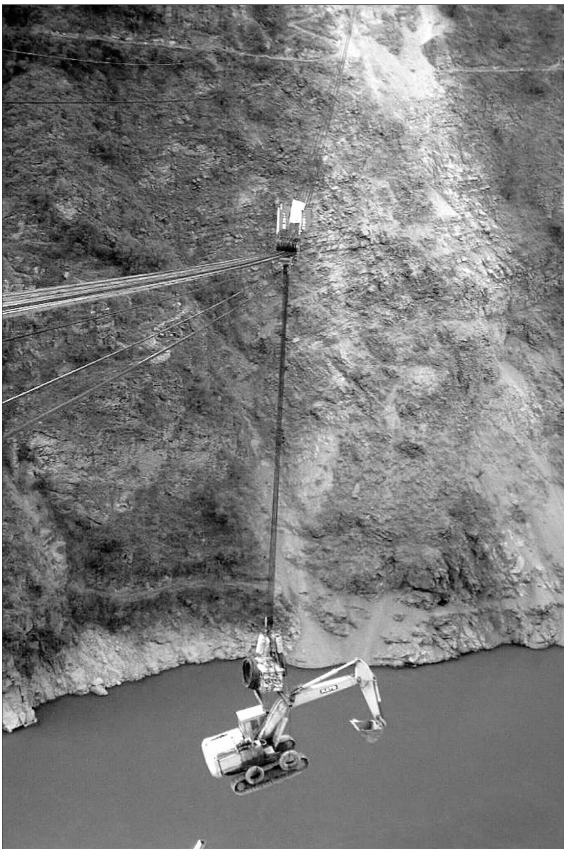
▲缆索起重机吊运挖掘机进入工地
