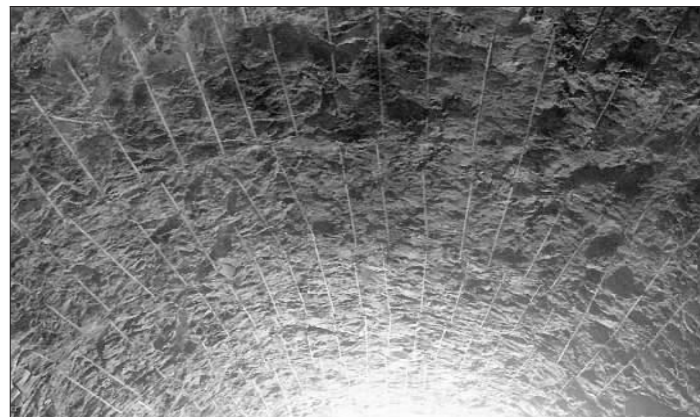
▲引水隧道光爆效果
