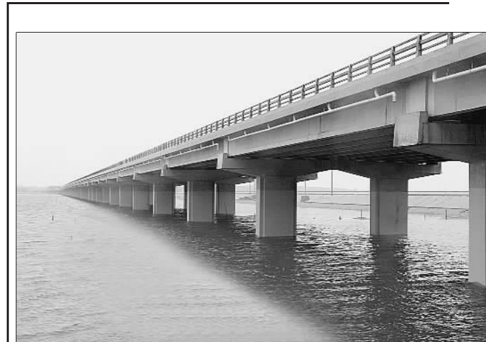
▲十九局集团五公司承建的青岛陈家贡海湾特大桥 杨秀权 摄
