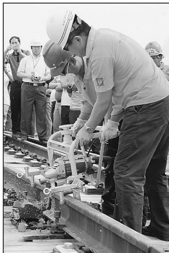
▲轨端焊接打磨
