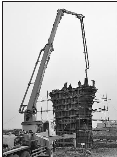
▲涪江3号桥墩柱浇筑
