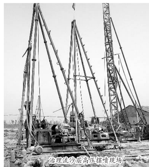
治理流沙层高压摆喷现场
