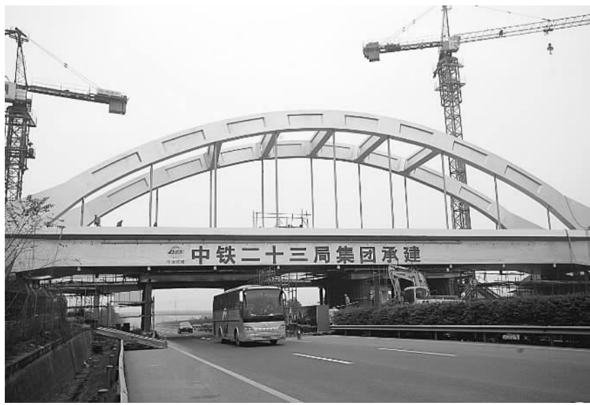
成昆铁路货车外绕线绕城立交双线特大桥——国内最重横桥梁成功顶推就位。
