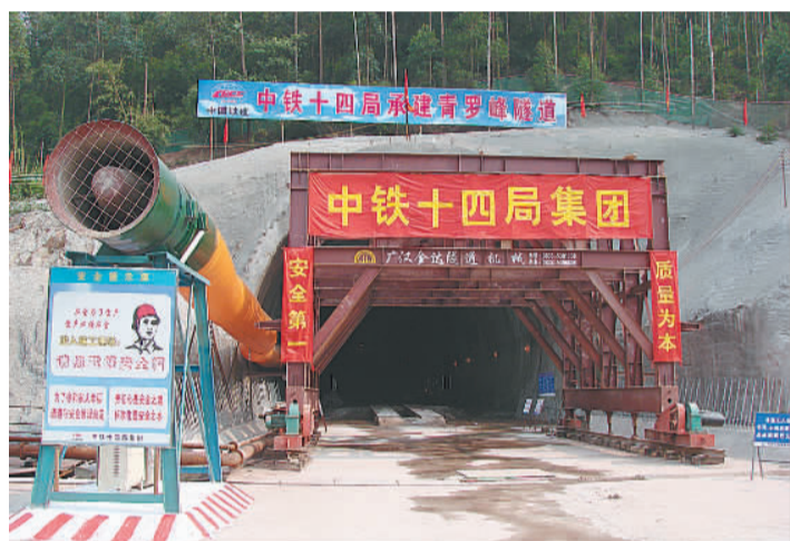
青罗峰隧道进口
