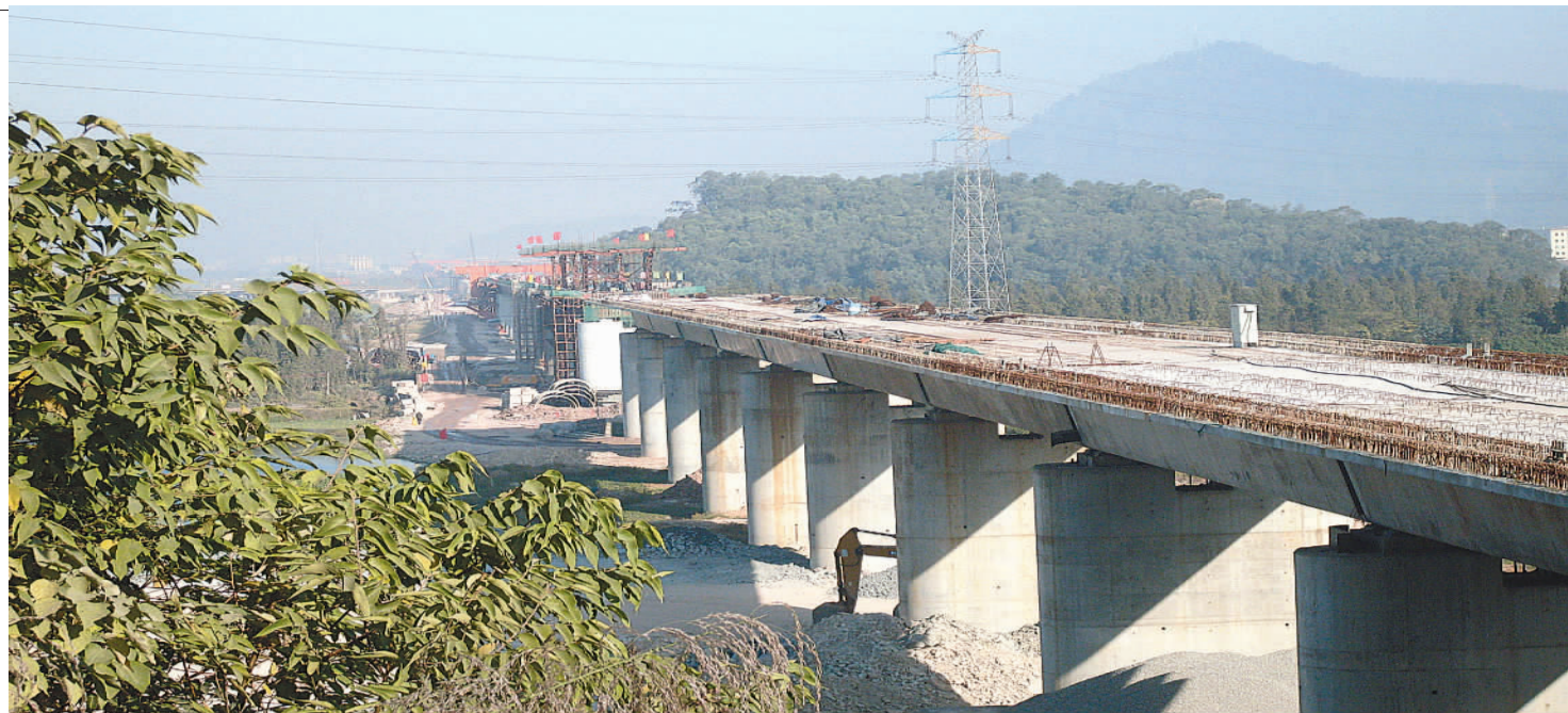
屏山涌特大桥
