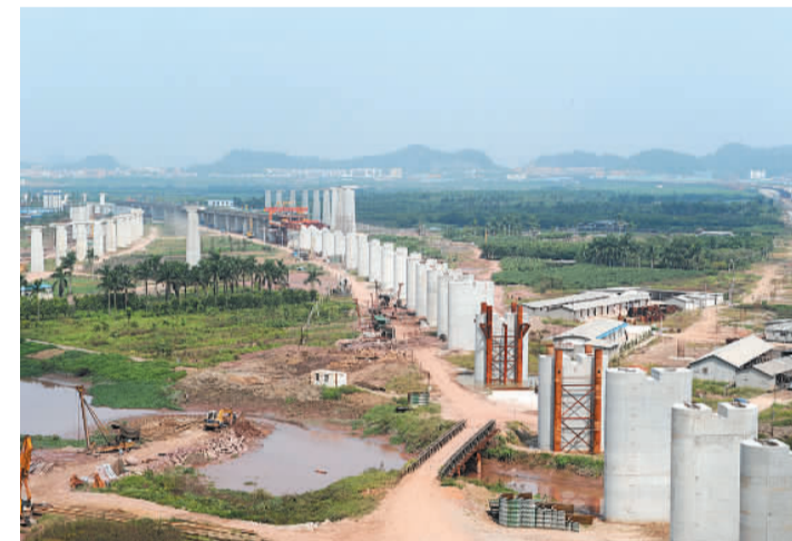
正在施工的屏山涌特大桥
