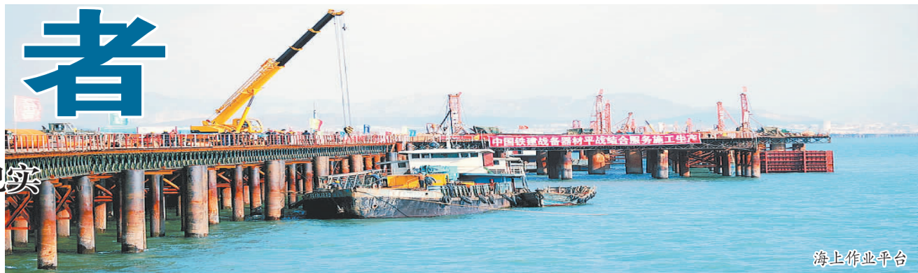
海上作业平台
