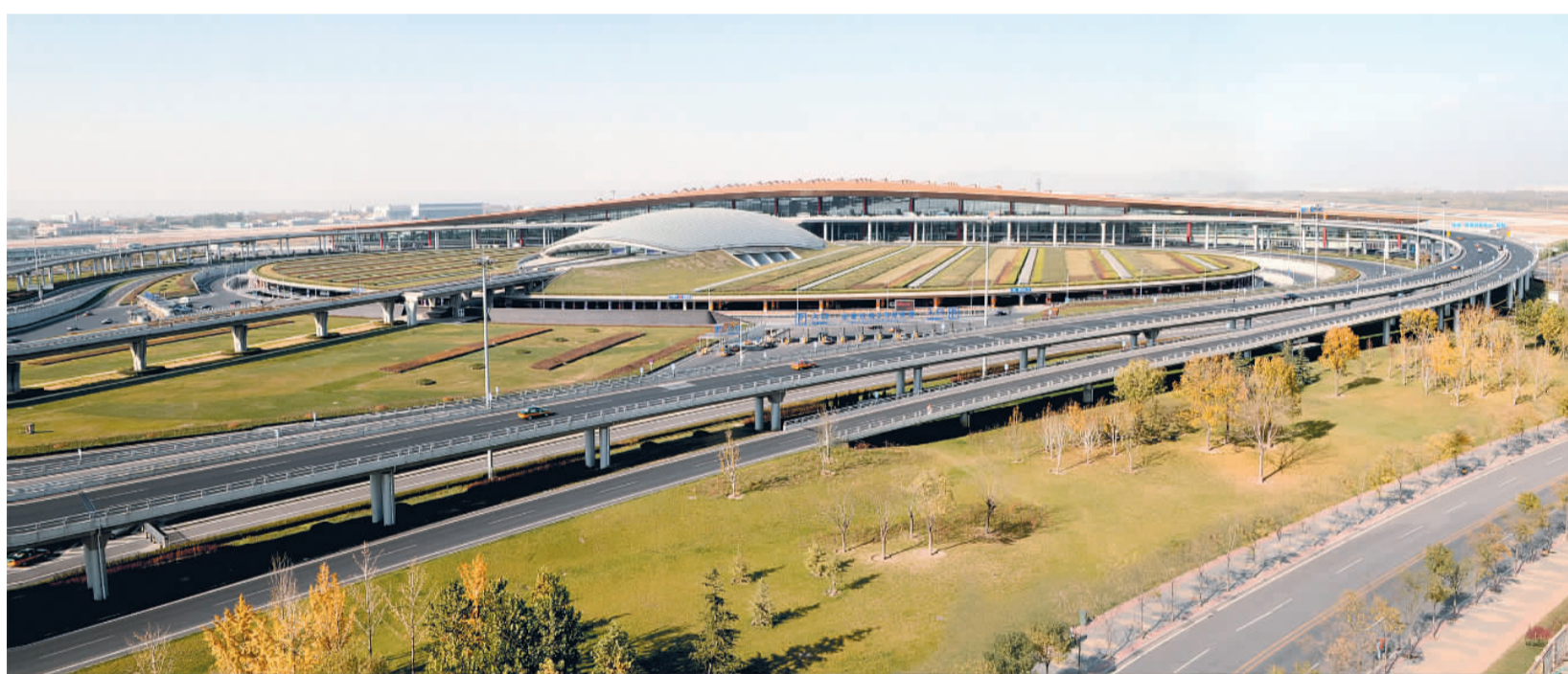
十二局集团二公司在首都机场建设中,以精细化管理铸精品工程,展现了优势企业的风采。图为已竣工的首都机场航站楼前交通工程。 廖高山 摄
