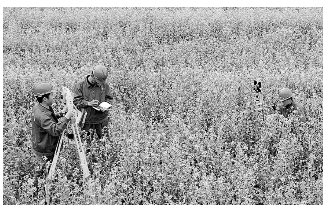
中铁十二局集团二公司包西铁路项目部,21名测量人员担负5座隧道、5座大桥等施工测量任务,做到及时准确无误,为工程创优奠定了基础。图为他们在放护桩时的情景。 廖高山摄
