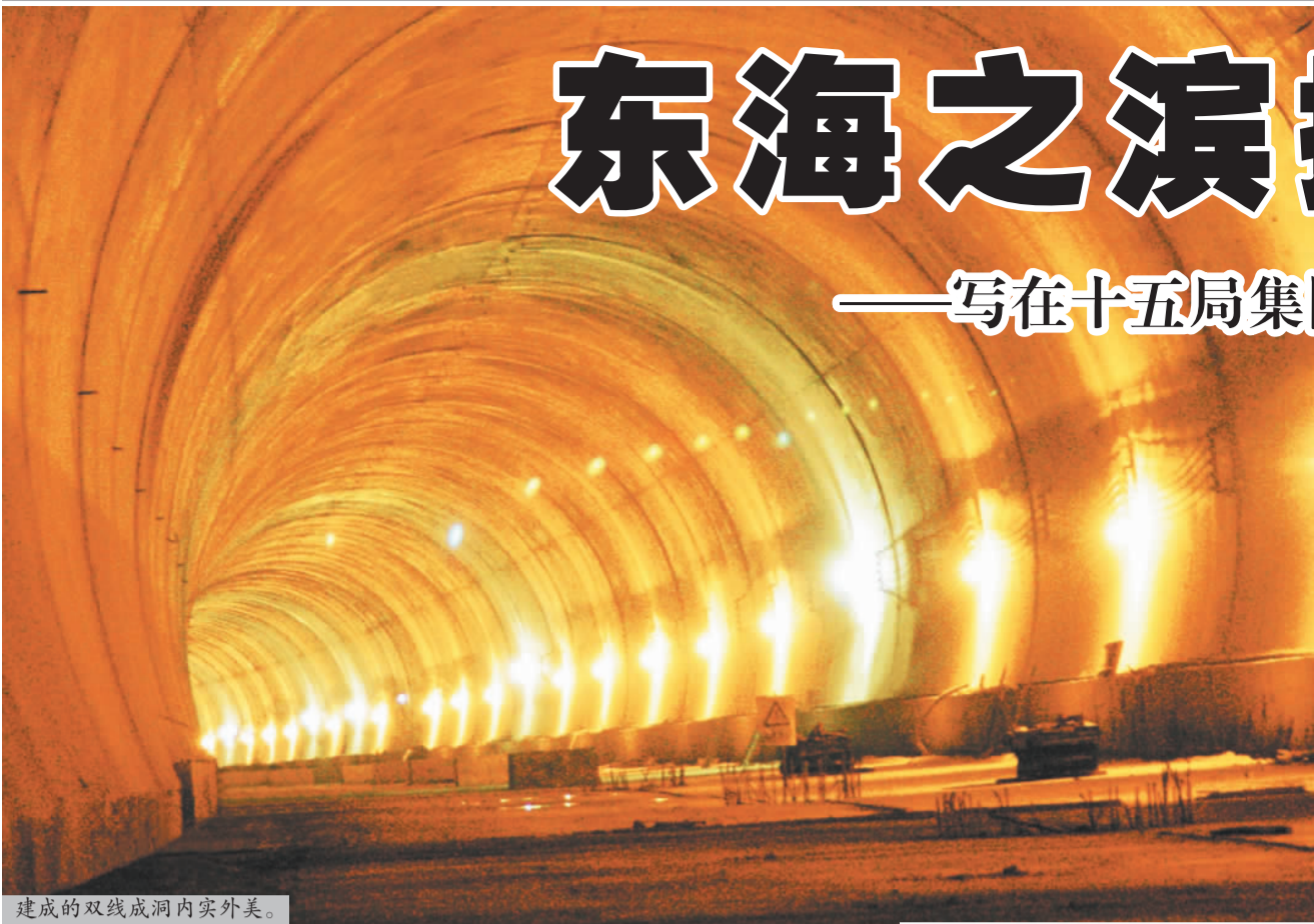
建成的双线成洞内实外美。
