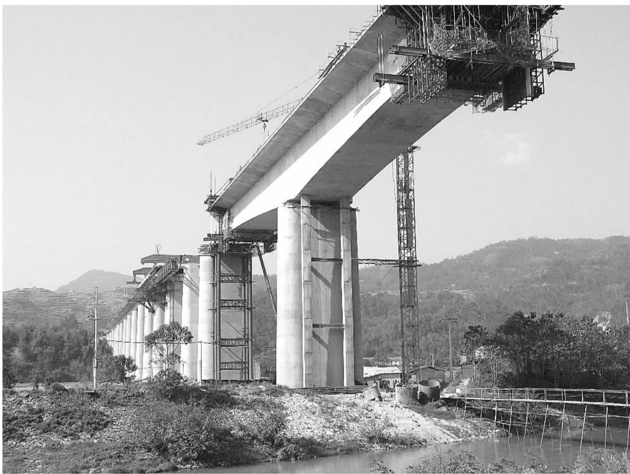
担负甬福客专运专桥墩特大桥施工任务的十一局集团建筑安装工程公司项目部,全面推行定岗、定员、定责的流程化、专业化、标准化管理,使大桥内实外美,成为全线的一大亮点,被评为优质样板工程。
